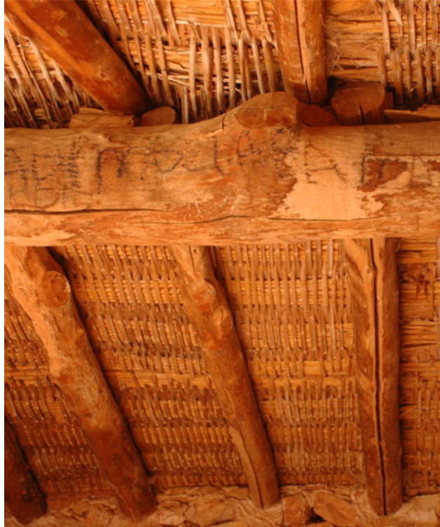
Figura 4. Vigas de un granero
